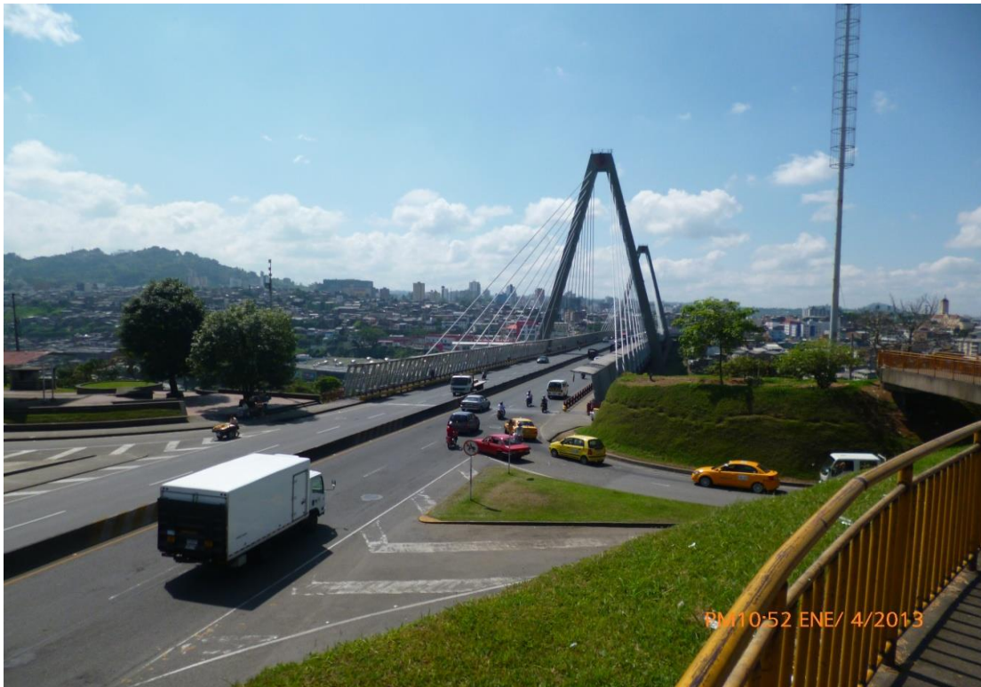
VIADUCTO EN PEREIRA
