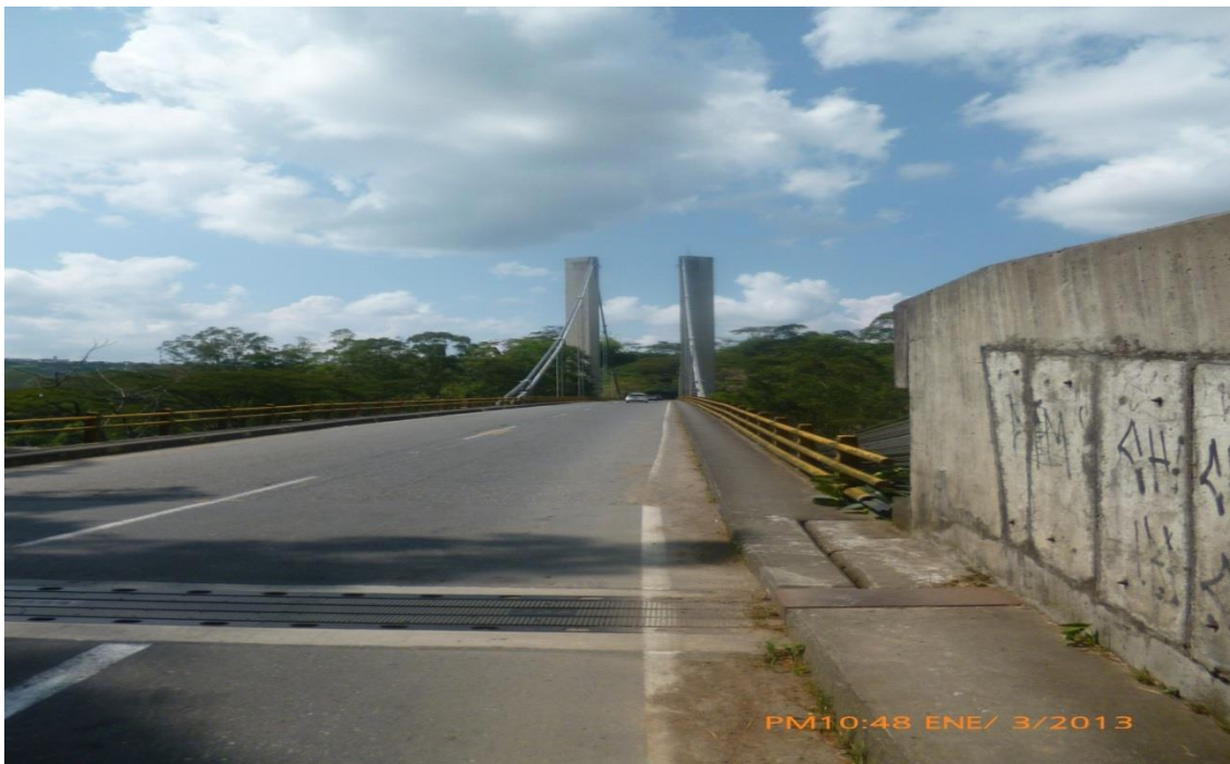
CRUZANDO EL PUENTE EN CHINCHINA
